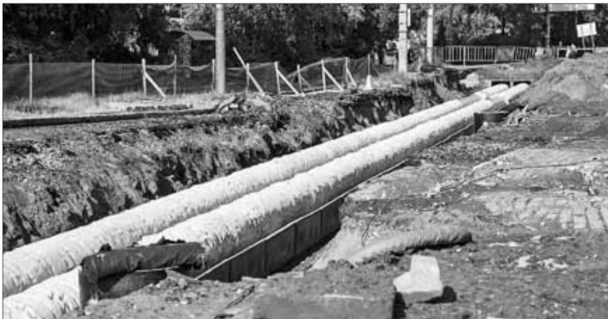
Изолированные трубы меняют на новые участками. ФОТО: СЕРГЕЙ СУРИН
